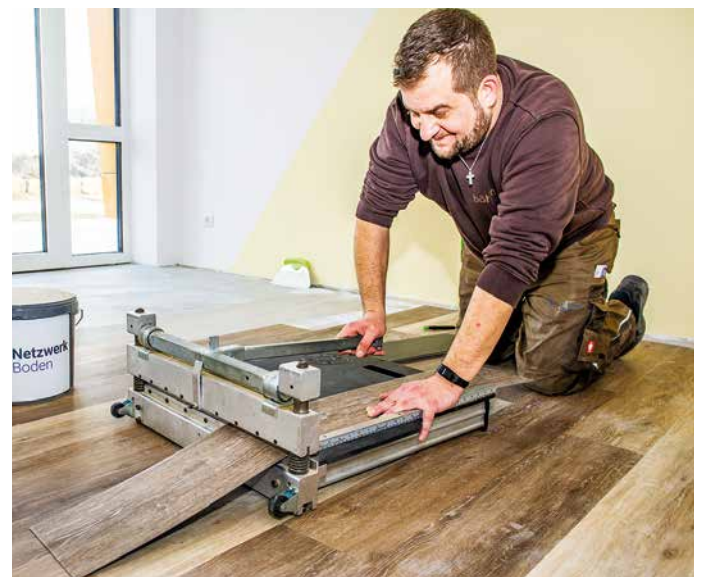
Exakte Verlegung: Die LVT-Planken müssen genau abgemessen und geschnitten werden, damit das Muster passt und die Optik perfekt ist. Fotos: Netzwerk Boden
