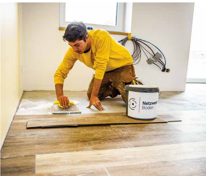
Unterboden, Grundierung und Klebstoff ergeben den erforderlichen professionellen Systemaufbau für den Boden. Die Arbeiten und das Material wurden durch Mitgliedsfirmen von Netzwerk Boden gestiftet.
